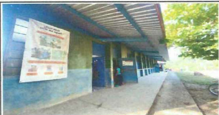
Foto 1: Pintura en los muros exteriores e interiores del establecimiento.
