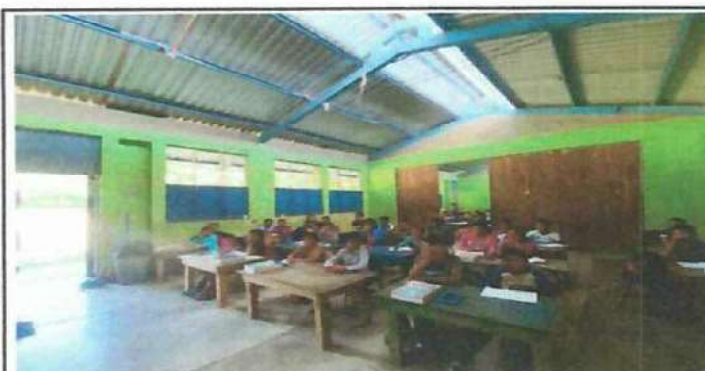
Foto 3: Sustitución de balcones en aulas debido a mala ventilación.
